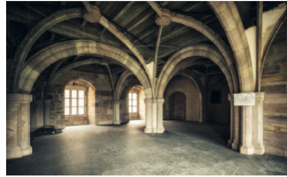
Wurde mit WORZELDORFER QUARZIT renoviert: die Cadolzburg
